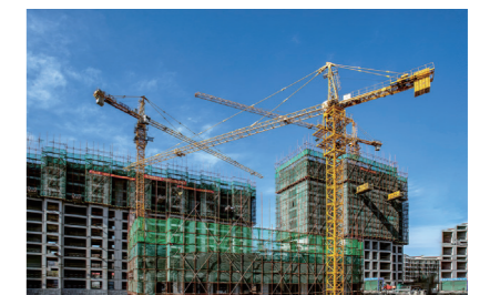
建筑测量与工程监测
